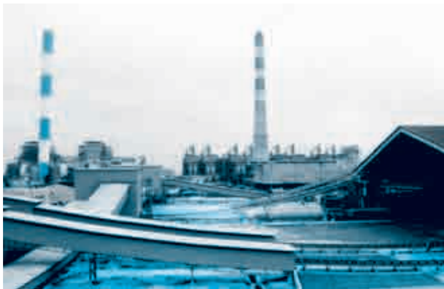
Nhà máy nhiệt điện Phả Lại
